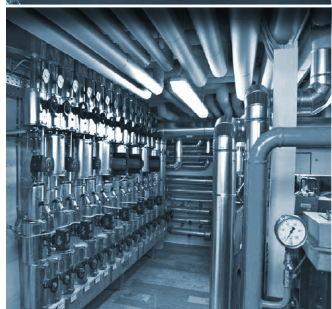
Sistemi di climatizzazione
