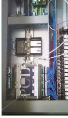
控制柜内部：Saia®PCD.M5540连接Profibus
