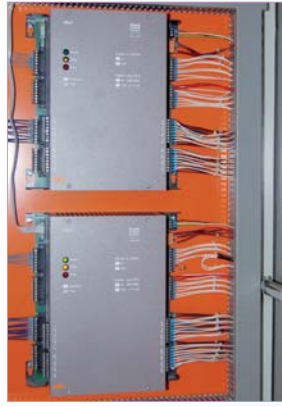
转换前后的控制柜: 左边的为现有的Staeffa控制柜, 右边的为装有PCD2.M5540的Saia-Burgess控制的转换设备
