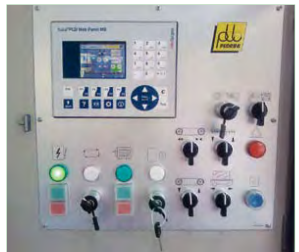
Het bedienpaneel van de nieuwe machine met het 3.5" Saia®PCD Webpanel als middelpunt
