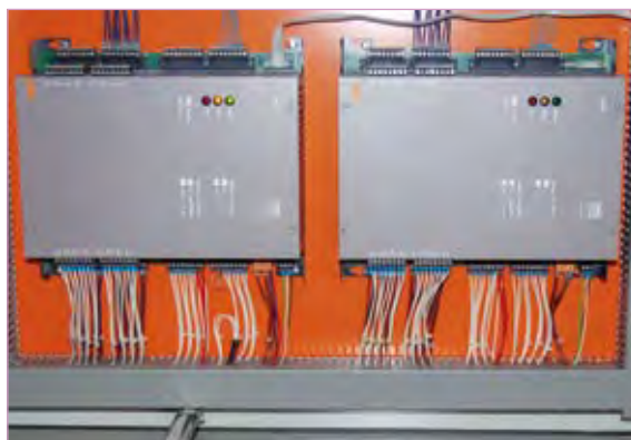
Schakelkast voor en na de ombouw: links de bestaande Staefa controller, rechts de Saia-Burgess Controls ombouwset met PCD2.M5540
