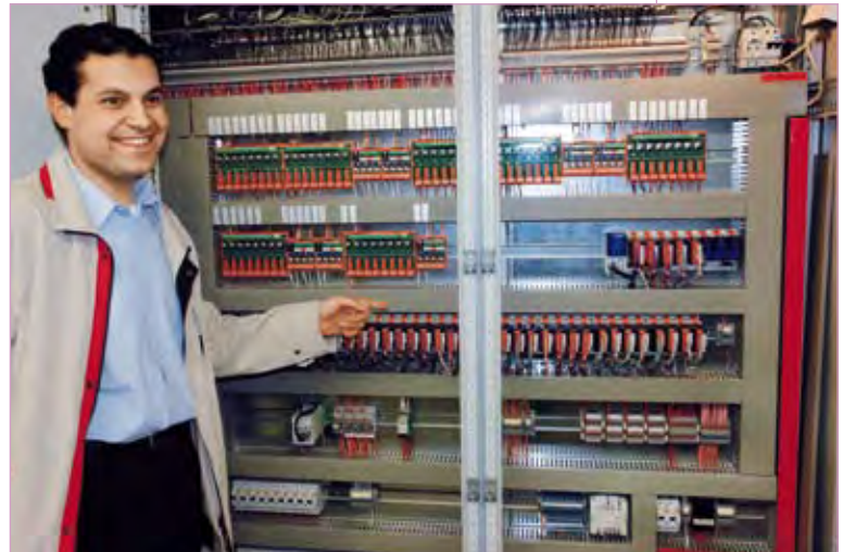
Een van de besturingskasten in de utilityruimte bij ASML. Te zien zijn onder meer Saia®PCD van het type PCD3.M5540.
