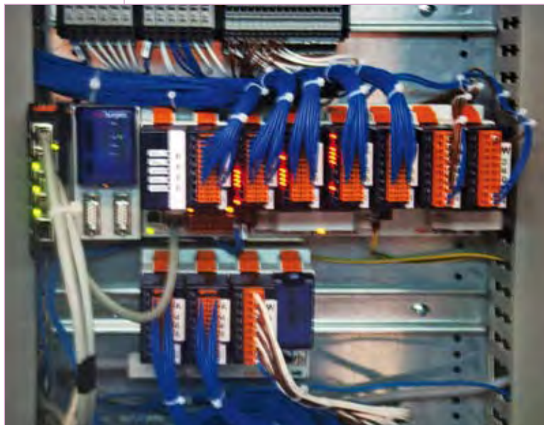
De schakelkast van een pompstation met Saia®PCD3 controller
