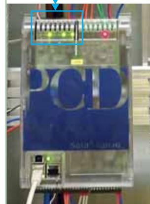
▲ Vista del quadro elettrico Saia®PCD1.M2120 con modulo M-Bus
