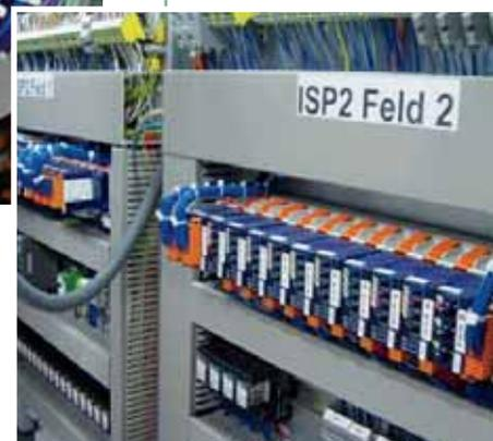
▶ Saia® PCD3 con moduli di uscita, funzionamento manuale incluso
