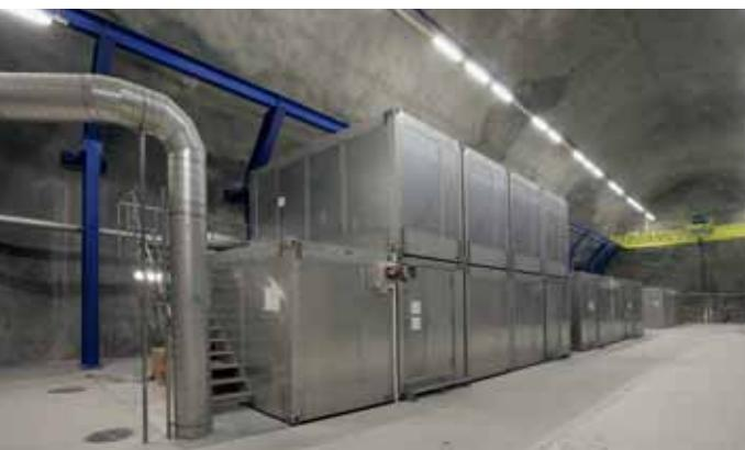
▲ Una delle 8 nicchie. I container climatizzati in acciaio inox contengono i sistemi di controllo ferroviari
