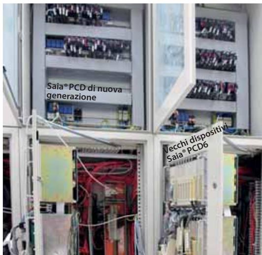
▲ Immagini dei quadri elettrici nuovi (in alto) e vecchi (in basso). Il nuovo quadro elettrico con Saia PCD 3 è stato installato e testato, senza dover fermare la produzione gestita dai "vecchi" dispositivi Saia®PCD6
