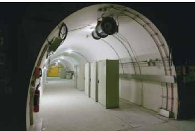
▲ Uno dei 104 tunnel di connessione. In ognuno di questi tunnel sono installati 15 quadri di controllo
