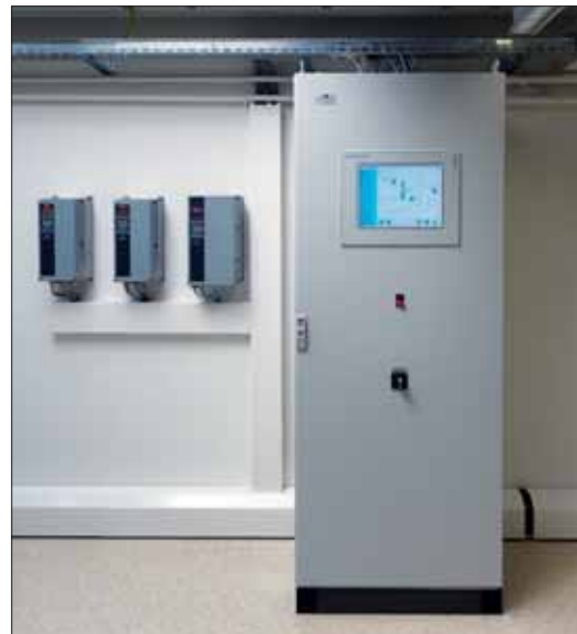
▲ Armoire de commande de l'installation de ventilation conçue pour la formation (certifiée POM Gold)
