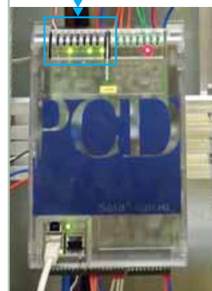
▲ Section armoire de commande Saia®PCD1.M2120 avec module M-Bus
