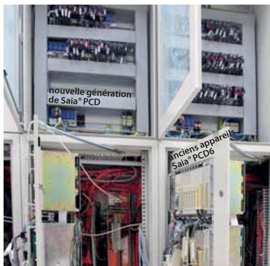
▲ Images de la nouvelle armoire de commande (en haut) et de l'ancienne armoire de commande (en bas). La nouvelle armoire équipée du Saia®PCD3 a été installée et testée sans interrompre la production avec les «anciens» appareils Saia®PCD6
