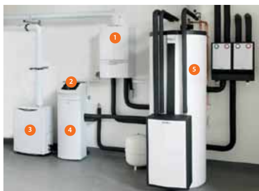
▲ Système de micro-cogénération de Vaillant Source : groupe Vaillant
