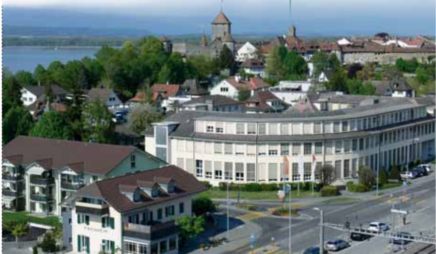
▲ Siège social Saia-Burgess Controls, Morat/Suisse
