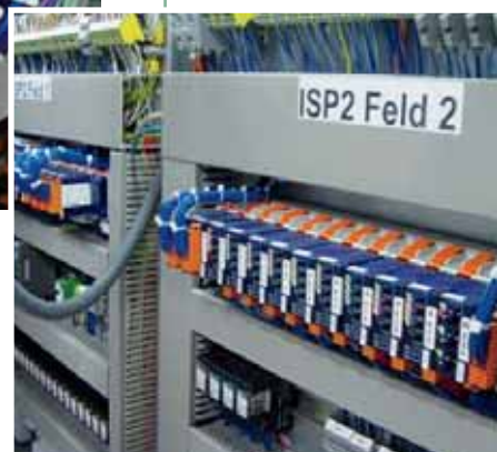
▲ Saia® PCD3 avec modules E/S pour capteurs / actionneurs conventionnels
