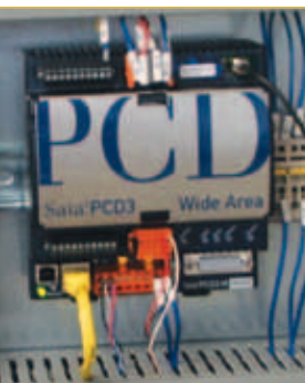
Saia®PCD3.WAC intégré et son câble d'antenne GSM Coupleurs M-Bus et Modbus avec la périphérie Carte de mémoire flash SD sous le capot argenté du PCD
