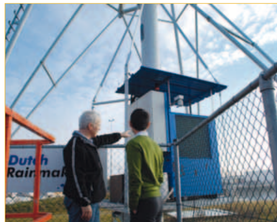
Le compresseur et l'armoire électrique, au pied du mât de l'éolienne.
