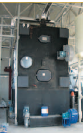
Installation de chauffage central en Ukraine
