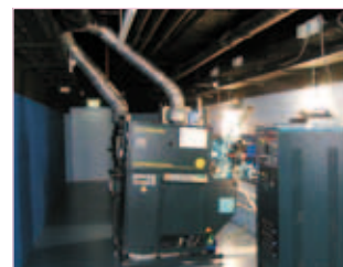
Pathé Westside : projecteur équipé en Saia®PCD
