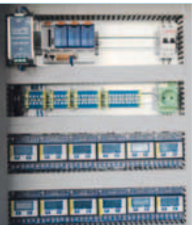
42 compteurs Saia® S-Bus et un automate Saia®PCD3.M3120 supervisent les consommations d'énergie du centre informatique de l'aéroport.
