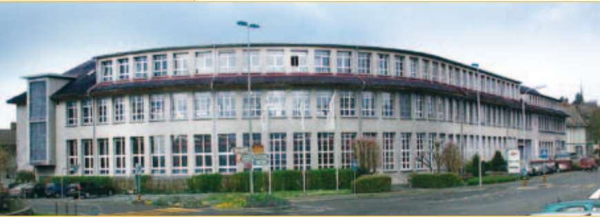
Saia-Burgess Controls Siège social de la rue de la Gare 18 à Morat
