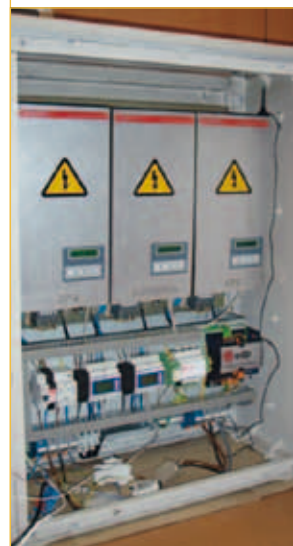
Armoire électrique avec commande Saia®PCD3.WAC modèle edp
