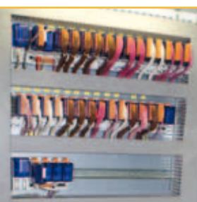
Tous les équipements techniques des commerces Airport Plus sont pilotés par des automates Saia®PCD3 sous BACnet®.
