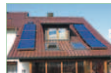
Installation solaire sur une maison individuelle
