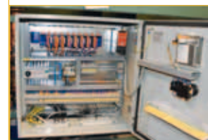
Coffret renfermant le Saia®PCD3 et l'afficheur PCD7.D232
