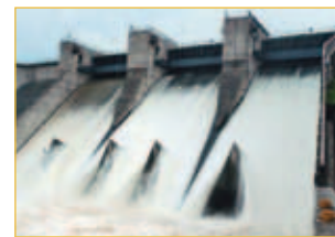
Barrage fluvial au sud de la Pologne 88
