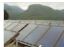
Installation solaire industrielle
