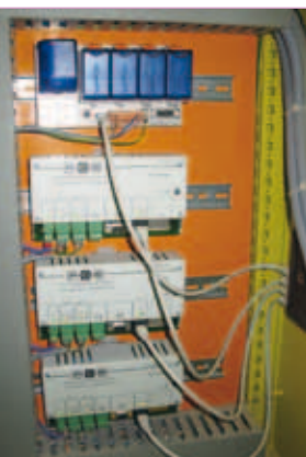
Activation de passerelles par unité centrale Saia®PCD3
