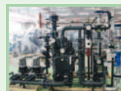
Danfoss mise sur Saia®PCD
