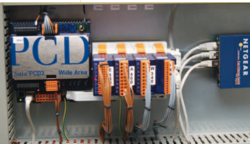
Contrôle-commande d'une installation de chauffage par Saia®PCD3.WAC avec modem intégré
