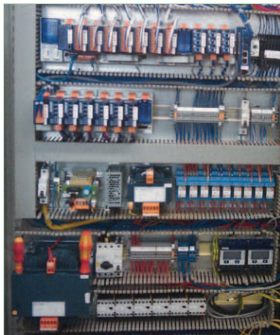
Armoire de commande typique d'une grande installation Agila avec Saia®PCD3, compteur d'énergie Saia® et Saia®Switch
