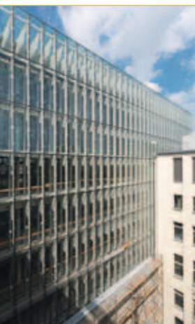
L'imposante façade vitrée optimise la lumière du jour
