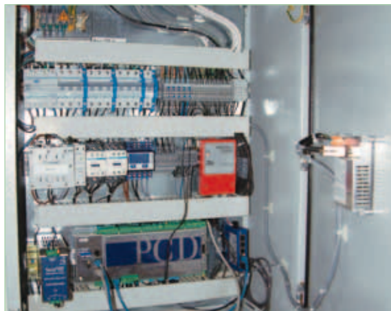
Armoire de commande ATMOVA standardisée, équipée d'un Saia®PCD3.M90 Controller (produit OEM), d'un compteur d'énergie Saia®, d'un Saia®Switch, d'une alimentation Saia® et d'une IHM Saia®.
