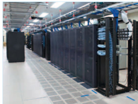
Centre informatique de l'aéroport d'Hanovre
