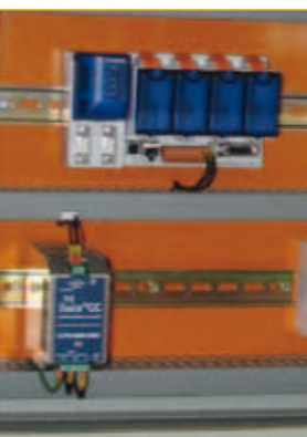
Pilotage par automates Saia®PCD
