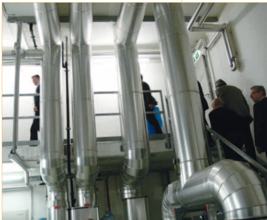
La visite sur site d'une installation a été une expérience impressionnante pour tous les clients et prospects de nos événements
