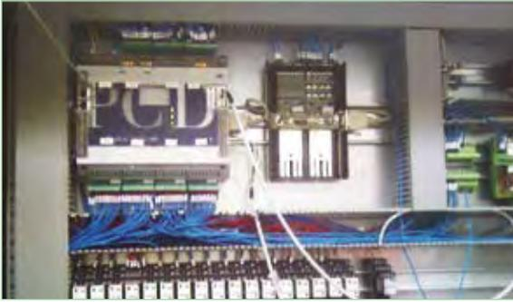
Armoire de la nouvelle machine équipée d'un Saia®PCD2.M5540 à coupleur Profibus
