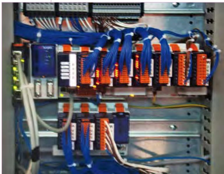
Armoire de commande de la station de pompage abritant des automates
