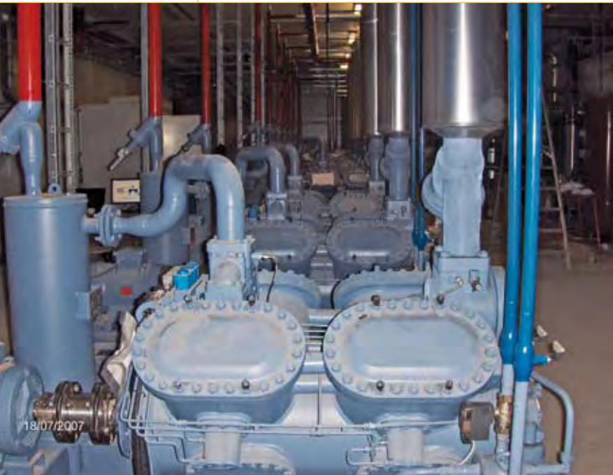
Le projet de 35000 m<sup>2</sup> récemment mis en service chez Asko Vest, près de Bergen, repose sur 2 automates Saia®PCD3 dotés de 200 E/S analogiques qui mesurent la température et la pression de 11 compresseurs à piston Grasso et de plus de 60 évaporateurs.
