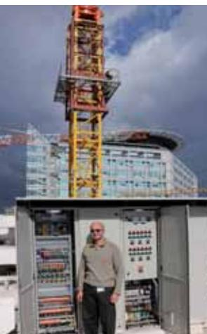
▲ Schaltschrank steht auf dem Dach des Krankenhauses unter der glühenden Sonne im nahen Osten: eine Herausforderung für die SPS-Technik!
