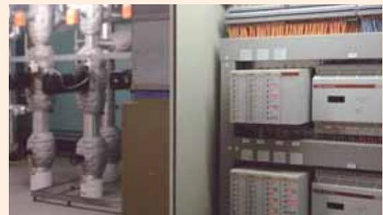
▲ Primäranlage bei AMC Hospital mit «altgedienten» Saia®PCD4 und Saia®PCD2 im Schaltschrank.
