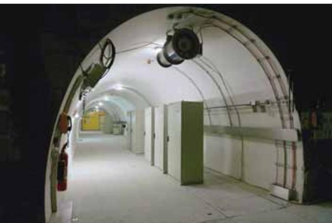
▲ Einer von 104 Querschlägen. In jedem Querschlag befinden sich bis zu 15 Schaltschränke.
