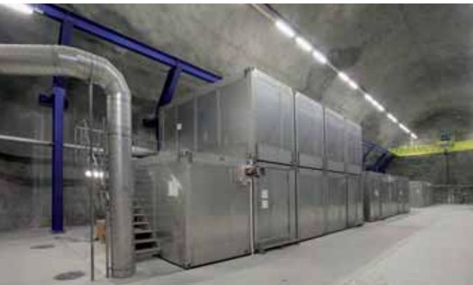
▲ Eine von 8 Tunnelkavernen. In den klimatisierten Edelstahl-containern ist die Bahn-technik untergebracht.
