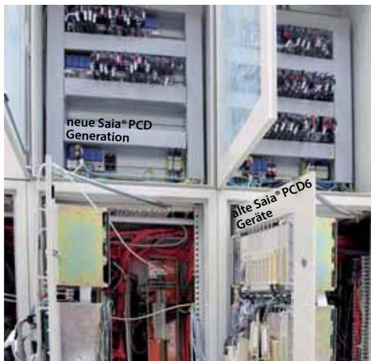
▲ Bilder vom neuen (oben) und alten (unten) Schaltschrank. Der neue Schrank mit Saia PCD 3 wurde installiert und getestet, ohne die Produktion mit den «alten» Saia®PCD6-Geräten zu stoppen
