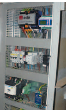
Saia®PCD3.WAC mit personalisierter edp-Abdeckung
