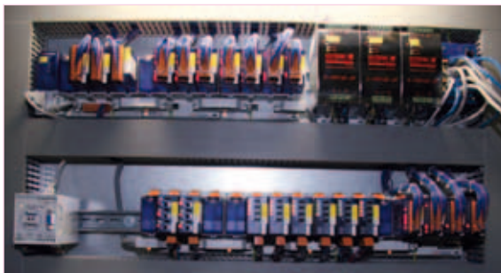
Insgesamt übernehmen vier Steuerungen der PCD3-Reihe die Steuerung von Heizung, Lüftung und Beleuchtung
