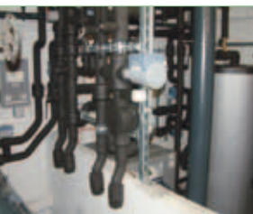
Die ATMOVA-Anlage von Swissmetal gewinnt die Wärme aus Bronzedachziegeln. Gesteuert wird die Anlage mit Saia®PCD-Technik
