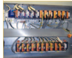
Saia®PCD3-Installation im Post- und Fracht-Terminal
