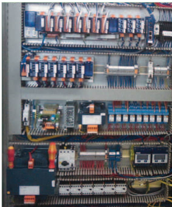
Typischer Schaltschrank einer Agila-Grossanlage mit Saia®PCD3, einem Saia®Energiezähler und Saia®Switch
