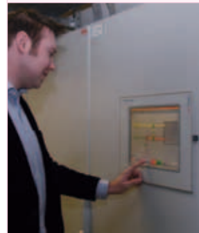
Beim Arbeiten im Technikraum ermöglicht ein Touchpanel der PCD7-Serie direkt vor Ort sinnvolle Eingriffsmöglichkeiten ins System
