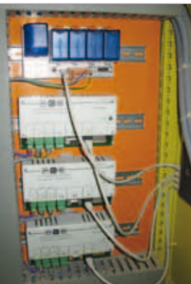
Ansteuerung der Gateways über Saia®PCD3-CPU
