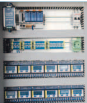
42 Saia® S-Bus Energiezähler und Saia®PCD3.M3120-Steuerung zur Energie-Erfassung im Rechenzentrum des Airports
