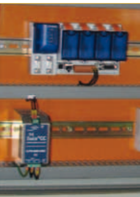
Solar Islands wird mit Saia®PCD gesteuert
