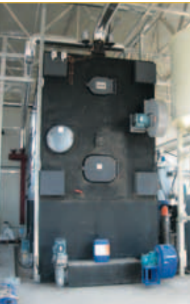
Heizzentrale in der Ukraine
