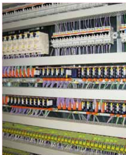
Schaltschrank der Firma Burkhalter Technics AG
