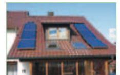
Solaranlage auf dem Einfamilienhaus
