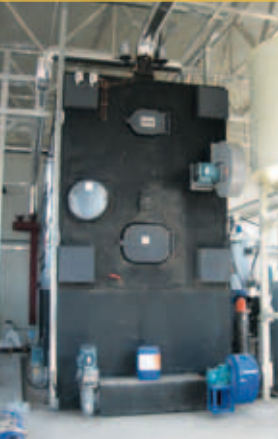
Heizzentrale in der Ukraine
