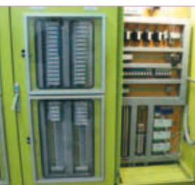
Gesamtübersicht des Schaltschranks inkl. bestehender Landis+Gyr Datenpunktmodule
