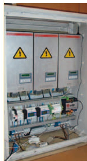
Schaltschrank mit Saia®PCD3.WAC-Steuerung in der edp-Ausführung
