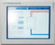
Lokale Bedienung über das 10" Saia®PCD Micro-Browser Web-Panel am Schaltschrank
