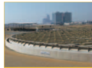
Solar Island Solarzellen-Insel im nahen Oosten 82
