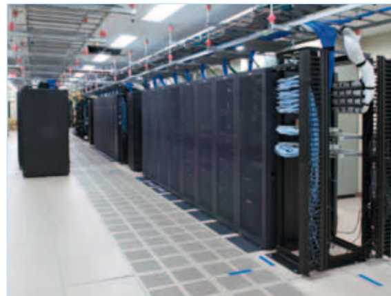
Rechenzentrum des Airports Hannover in Deutschland
