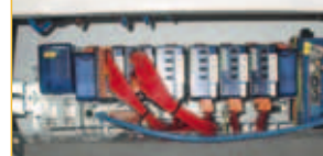
Eine der Saia®PCD3-Steuerungen im Firmengebäude bei Infocontrol Lda
