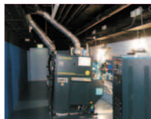
Pathé Westside: Projektoren mit Saia®PCD-Technik
