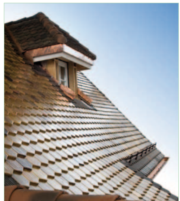
Haus der Energie; denkmalgeschütztes Haus aus dem 13. Jahrhundert
