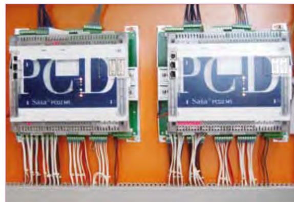
Schaltschrank vor und nach dem Umbau: links der bisherige Staefa Regler, rechts der Saia-Burgess Controls Umrüstsatz mit PCD2.M5540
