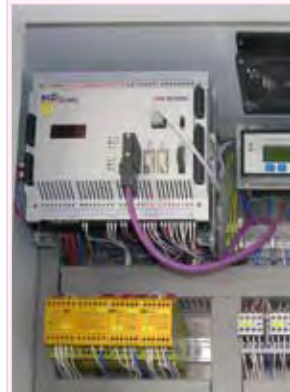
Saia®PCD2.M480 steuert alle Prozesse der Reinraummaschine
