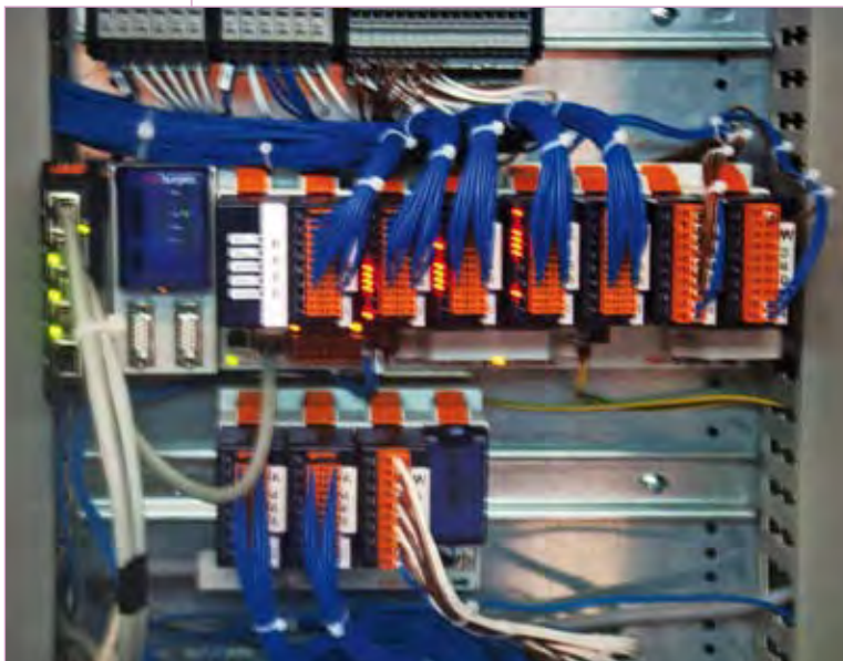
Schaltschrank von Pumpstation mit Saia®PCD3 Steuerungen
