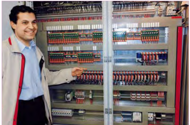
Der gut gelaunte Projektleiter des Kunden vor einem Schaltschrank mit einigen Saia®PCD3.M5-Steuerungen.
