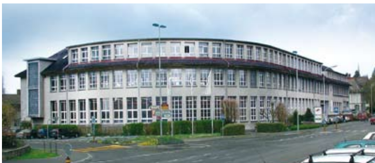
Neu ist die gesamte Saia®PCD Entwicklung, Produktion und Logistik nicht nur an einem Standort, sondern gar unter einem Dach vereint.
