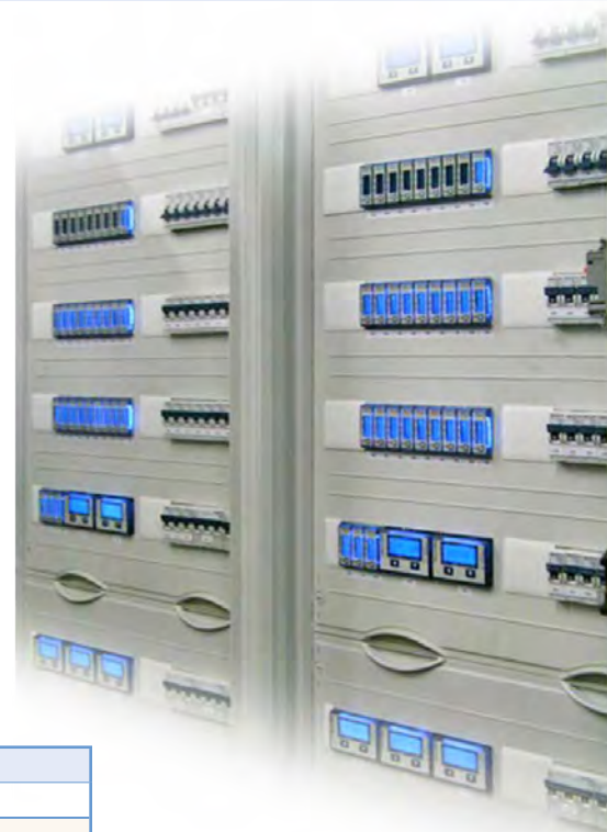
Groot aantal Saia PCD® energiemeters op klein oppervlak
