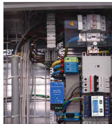
▲ Ingebouwde stroomtrafo in kabelgoot
