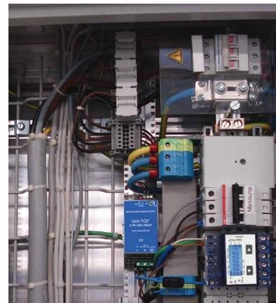
▲ Eingebaute Stromwandler direkt im Kabelkanal
