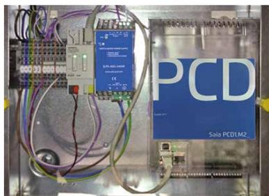
Raccordement à une installation EIB/KNX existante pour connexion Internet dans les salles de conférence
