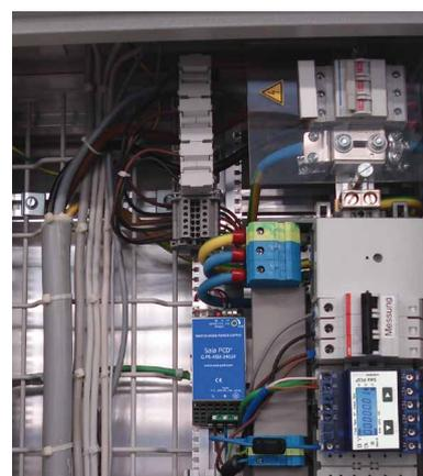
▲ Transformateur de courant intégré directement dans le chemin de câbles
