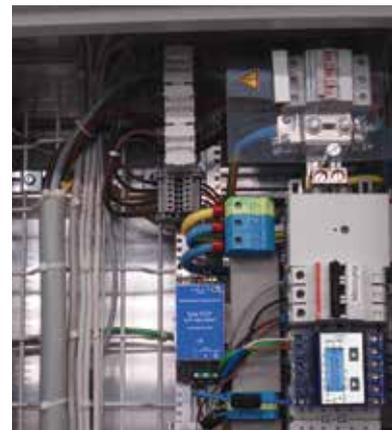
▲ Eingebaute Stromwandler direkt im Kabelkanal
